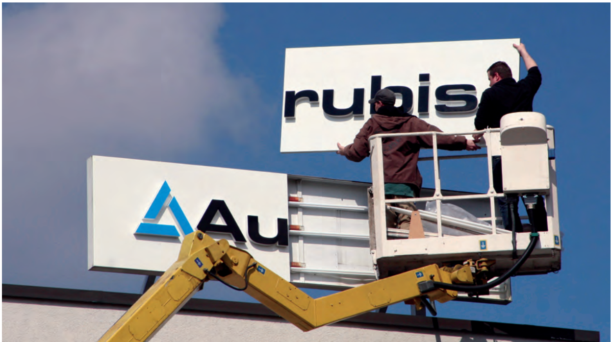
2009 war ein wichtiges Jahr für die Prymetall GmbH & Co. KG: Am Gebäude wird das Firmenlogo der Aurubis AG angebracht. Die heute rund 400 Mitarbeiter fertigen nun als Aurubis Stolberg GmbH & Co. KG jährlich 60.000 t halbfertige Kupfer- und Kupferlegierungsprodukte.
