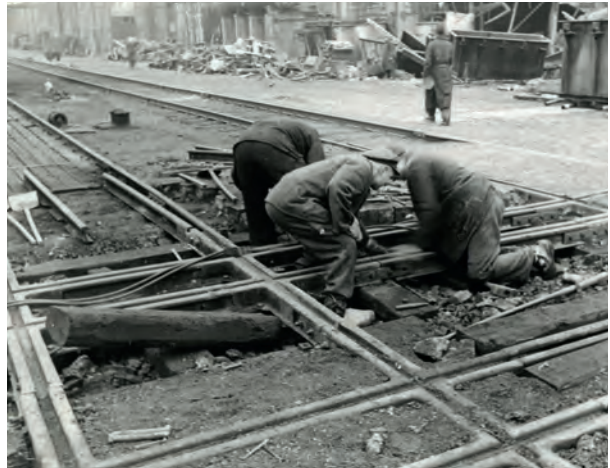
Reparatur von Straßenschäden an einer Gleiskreuzung auf dem Nordufer im November 1944.
