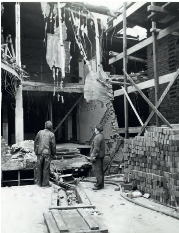
Eines der Werksgebäude mit Bombenschäden. Beim ersten direkten Luftangriff in der Nacht zum 9. Mai 1941 war das Werk noch glimpflich davongekommen. Im Sommer 1943 wurden Teile des Werks aber von mehreren hundert Bomben zerstört.
