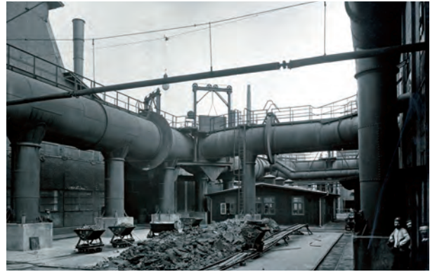
Abgasrohre im Hamburger Werk in den 1920er Jahren.
