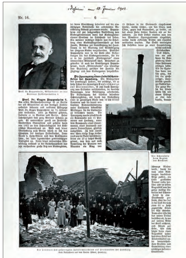
Ein 60.000 Zentner schweres Wahrzeichen des Hamburger Hafens verschwindet: Sprengung des 85 m hohen Schornsteins des Elbkupferwerks auf Steinwerder Ende 1901. Lange Zeit glaubte man, dass durch ausreichend hohe Schornsteine die Abgase in der Luft verteilt, verdünnt und somit unschädlich gemacht würden.
