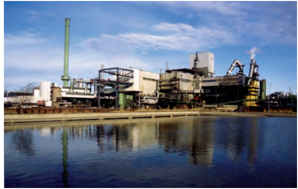
Zukunftssicher: Die Rohhütte Werk Ost (RWO), das Herzstück der Rohkupfererzeugung von Aurubis Hamburg, in einer aktuellen Werksansicht. Die RWO wurde immer wieder aus- und umgebaut und verbessert.
