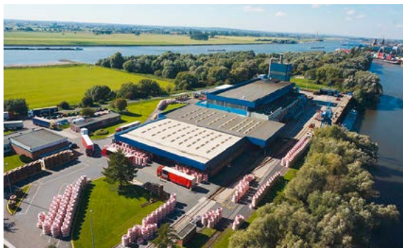
The Deutsche Giessdraht GmbH plant in Emmerich am Rhein.
